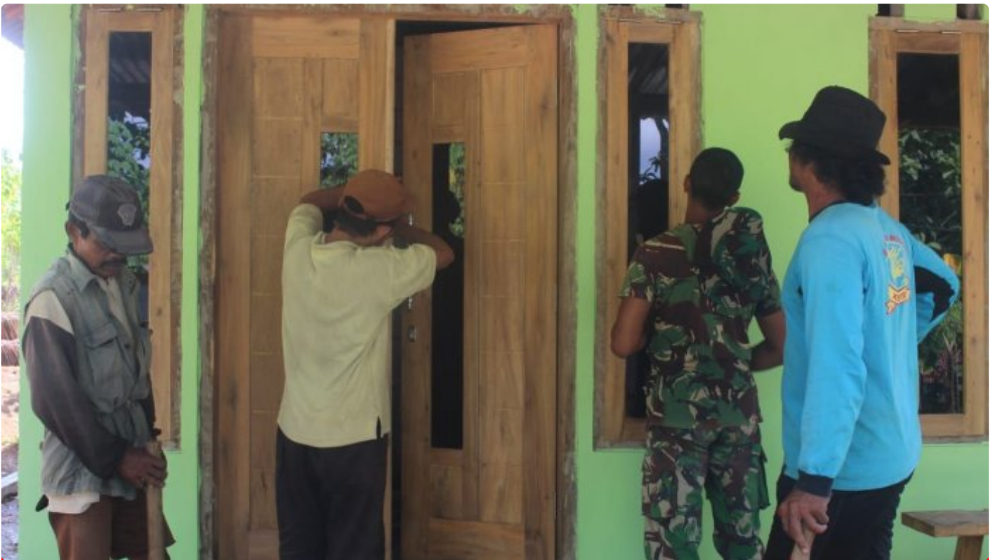
Kegiatan pemasangan daun pintu dan jendela rumah yang bertempat di Desa Pejengkolan
